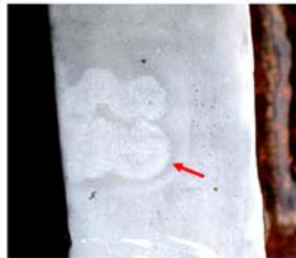
FIGURE 12 DÉTAIL DE LA ZONE DE RÉPARATION OBSERVÉE SUR LA FIGURE 11 DIMENSIONS: 10x13 mm
